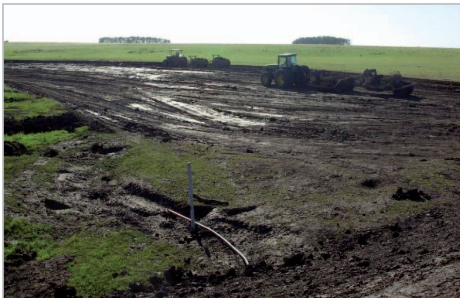
F. Aprvechamiento de cárcava para la colocación de la tubería.
